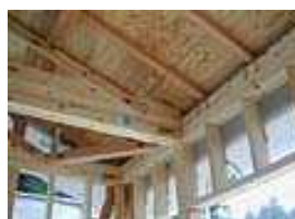
火打ち梁くら金物 屋根と梁を固定する
