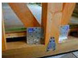
筋交金物 筋交と柱と土台を三位一体に
